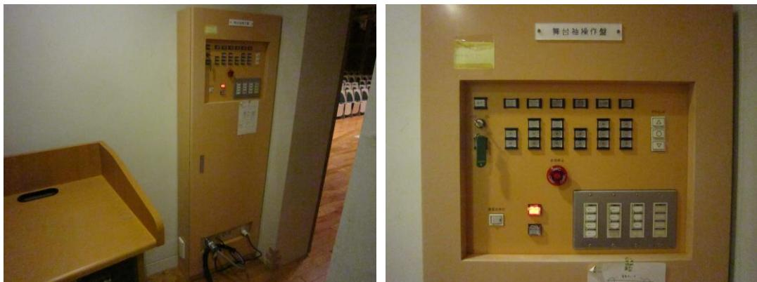
ブロックごとの照明 ON/OFF(調光はできません)および動力(ブラインド開閉、バトン昇降、スクリーン扉開閉)
