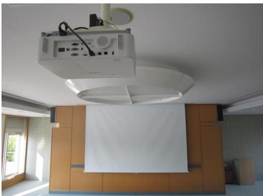
NEC NP-P554WJL (解像度 WXGA(1280×800))。天井に固定。
